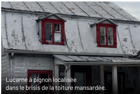
Fenêtre à battants à six grands carreaux dotée d'un chambranle.
